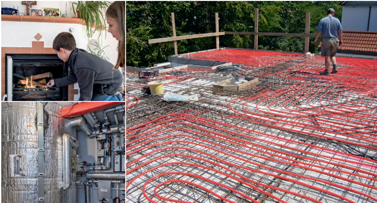
Mittels Betonkernaktivierung lassen sich große Mengen Wärme kostengünstig in den Geschossdecken speichern. Das System funktioniert wie eine Fußbodenheizung, dient aber vor allem der Wärmespeicherung im Beton.
