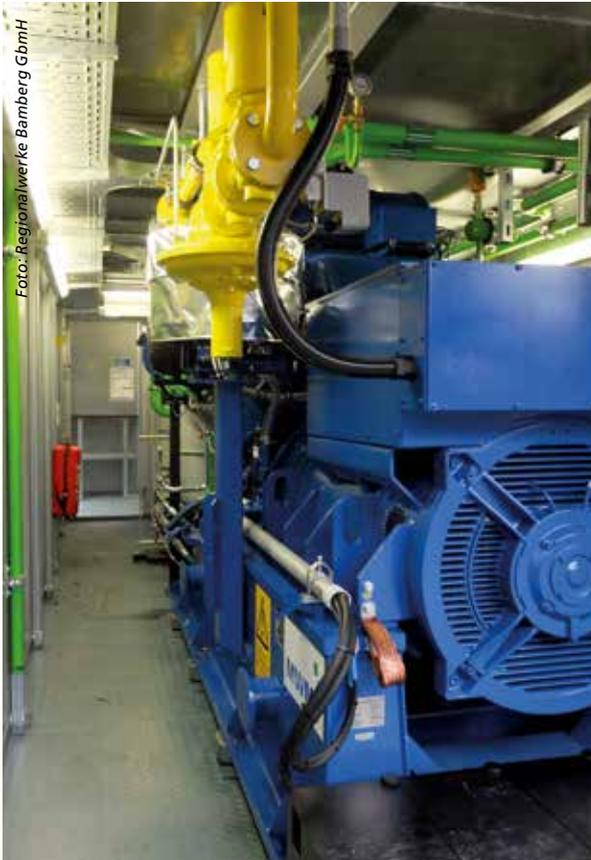
Die Kraft-Wärme-Kopplung (KWK) ist ein zentraler Baustein der Energiewende. Ein Blockheizkraftwerk (BHKW) produziert zugleich Strom und Wärme. Hierbei werden bei der Stromerzeugung elektrische Wirkungsgrade bis zu 42 % und thermische Wirkungsgrade von über 45 % erreicht. Aufgrund der gleichzeitigen Erzeugung und Nutzung von Wärme und Strom wird eine Primärenergieeinsparung von ca. 30 % im Vergleich zur konventionellen Erzeugung von Strom und Wärme erreicht.
