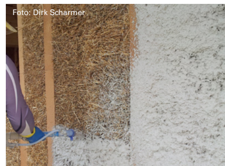
Putzaufbringen auf eine strohgedämmte Wand
