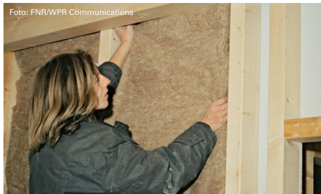
Einbau einer flexiblen Dämmmatte aus Hanffasern
