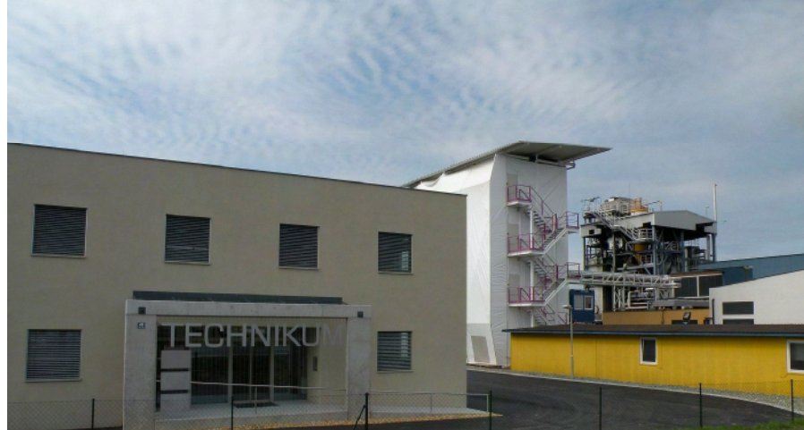
Bild 8-3: Technikum Güsing Quelle: Europäisches Zentrum für erneuerbare Energie Güssing GmbH
