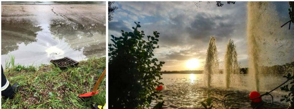
**Abbildung 34: Überschwemmte Fahrbahn nach einem verstopften Entwässerungseinlauf. Feuerwehr Bamberg (2018) (links). Einsatz des THW Bamberg am Westsee. Um ein Fischsterben aufgrund der hohen Gewässertemperaturen zu verhindern, wurde der See belüftet und mit Frischwasser angereichert (rechts).**
